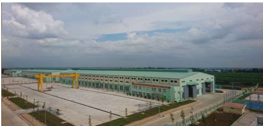
Nhà máy Z756, KCN Loteco, Đồng Nai
