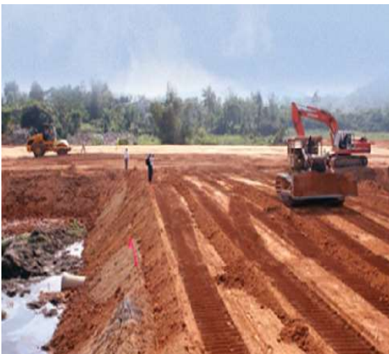
Thi công san lấp mặt bằng
