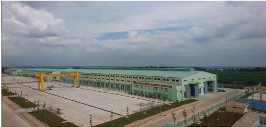
Nhà máy Z756, KCN Loteco, Đồng Nai
