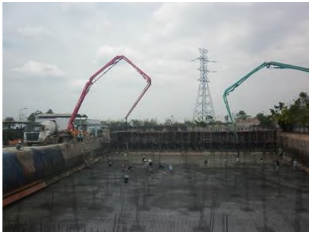
Bể xử lý nước thải KCN AMATA
