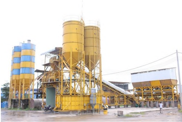
Trạm trộn Hồ Nai công suất 195m 3 /h
