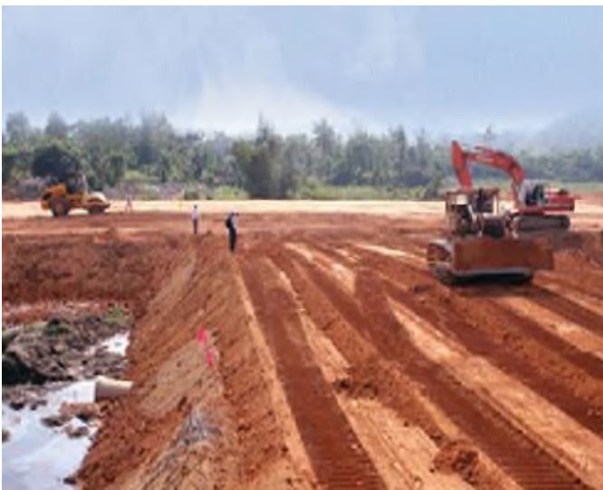
Thi công san lấp mặt bằng
