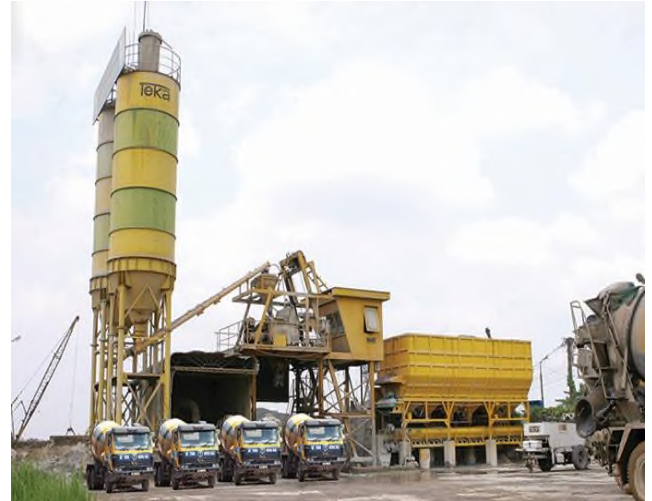
Trạm trộn An Bình công suất 60 m 3 /h
